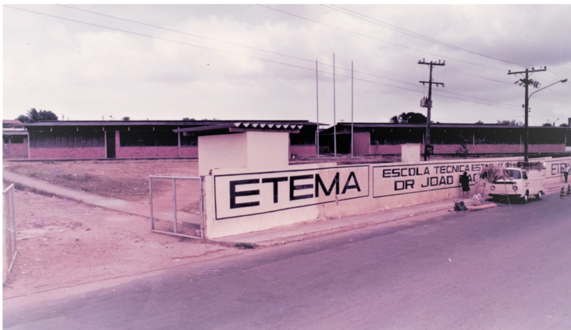
Figura 2 - Fachada do prédio
