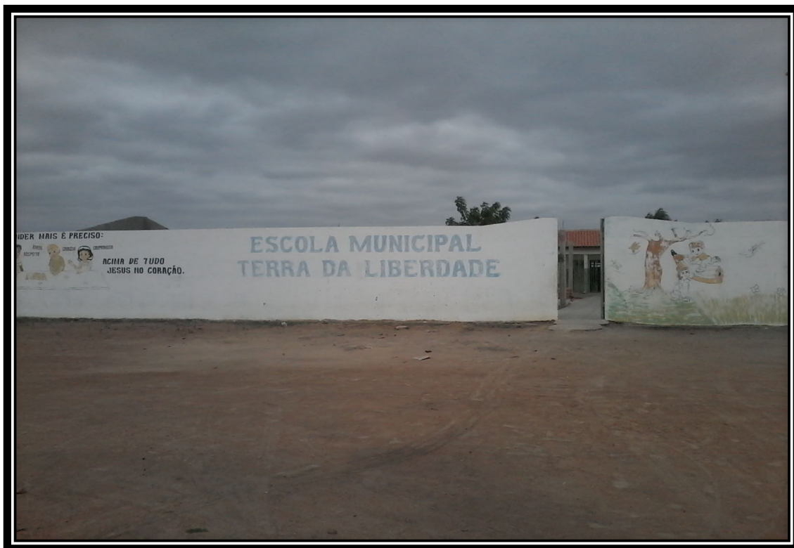
Figura 01: Escola Terra da Liberdade
